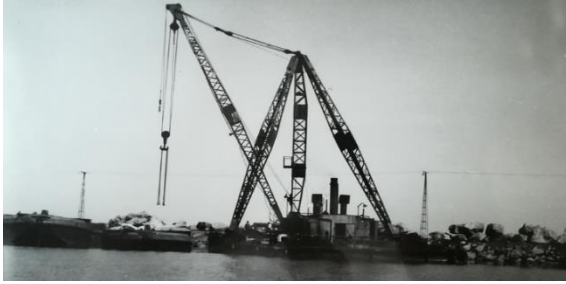
Resim: Yüzer Vinç (Liman İnşaatı Vasıtası)
